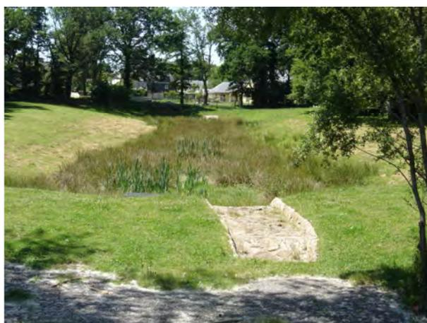
Dans l'hypothèse où ce dispositif serait constitué par des noues ou des dépressions paysagères, elles seront également enherbées. Les pentes de talus seront au maximum de 30% et devront avoir un profil en travers se rapprochant le plus possible d'une courbe sinusoïdale. On recherchera le plus possible à se rapprocher des caractéristiques et de l'intégration des aménagements ci-dessous.
