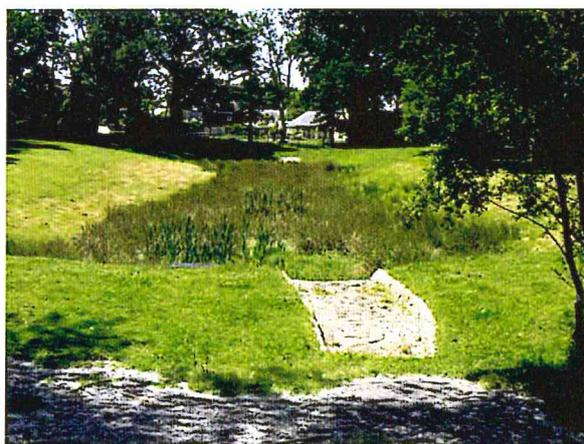
Dans l'hypothèse où ce dispositif serait constitué par des noues ou des dépressions paysagères, elles seront également enherbées. Les pentes de talus seront au maximum de 30% et devront avoir un profil en travers se rapprochant le plus possible d'une courbe sinusoïdale. On recherchera le plus possible à se rapprocher des caractéristiques et de l'intégration des aménagements ci-dessous.
